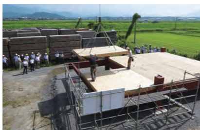
木材を床の構造材に用いた場合の問題点把握のための施工実験
