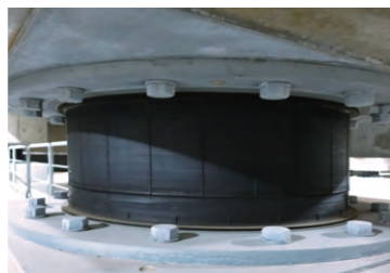
免震構造の積層ゴムの研究は、福岡大学が日本で最初だっって知っていました？
