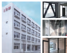
5号館総合改修
